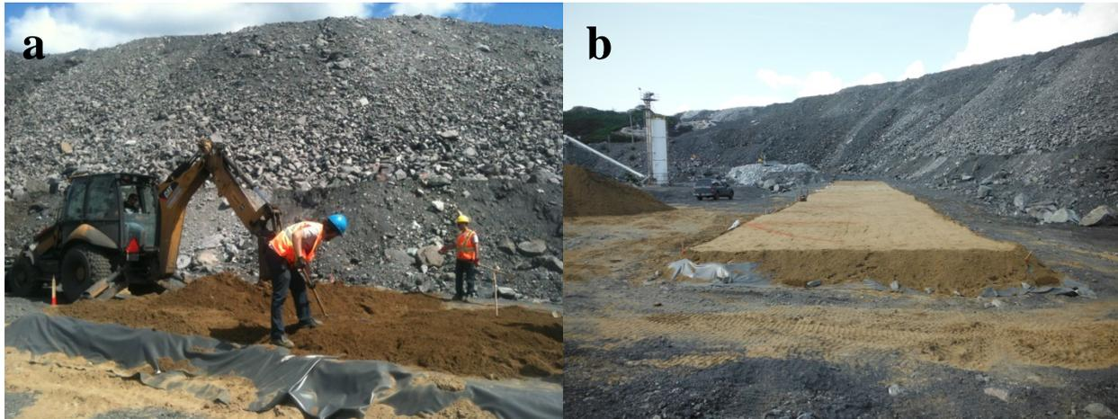
*Figure 8. Installation du sable par-dessus la membrane des lysimètres (a) et aperçu des lysimètres après compactage de la couche de sable de protection par-dessus la géomembrane (b)*
