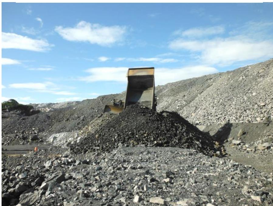
*Figure 13. Mise en place des stériles sur la halde expérimentale; on aperçoit le bouteur en arrière-plan qui attend pour pousser les stériles et régaler la pente*
