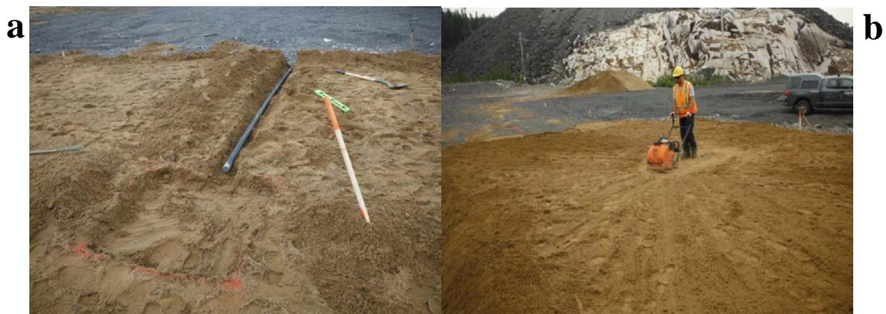
Figure 6. Aménagement du drain de collecte (a) et compaction de la couche de sable inférieure des lysimètres (b)
