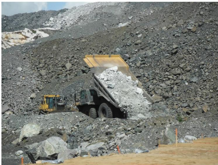
*Figure 12. Construction de la rampe de la halde expérimentale*
