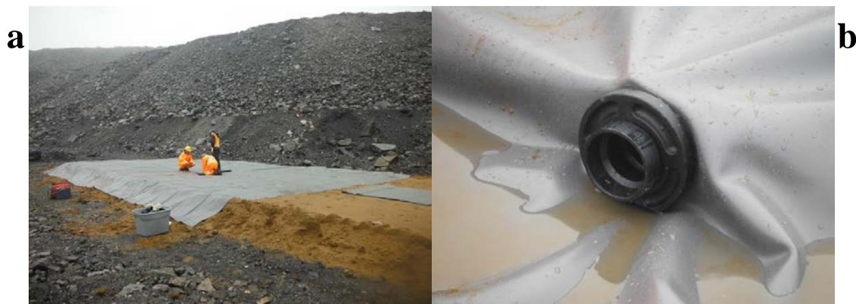
Figure 7 : Géomembrane déployée sur un lysimètre (a) et passe-paroi pour le drain après installation (b)
