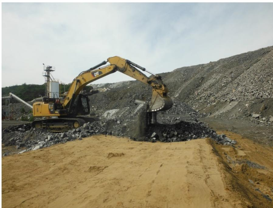
*Figure 11. Installation de la couche de stériles de protection des lysimètres à la pelle mécanique*
