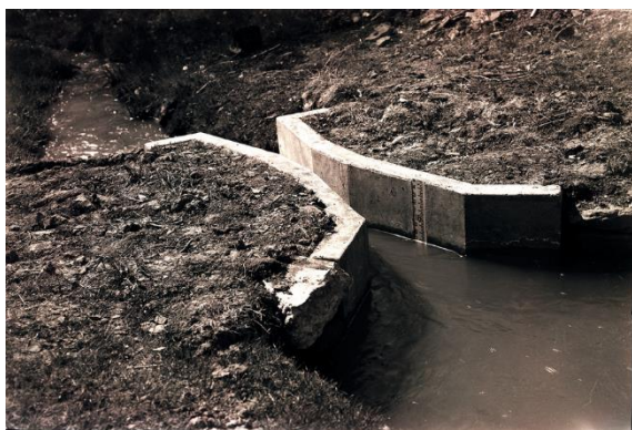
Figure 6.2 Exemple d'ouvrage de contrôle du débit (canal Parshall, déversoir en V)
