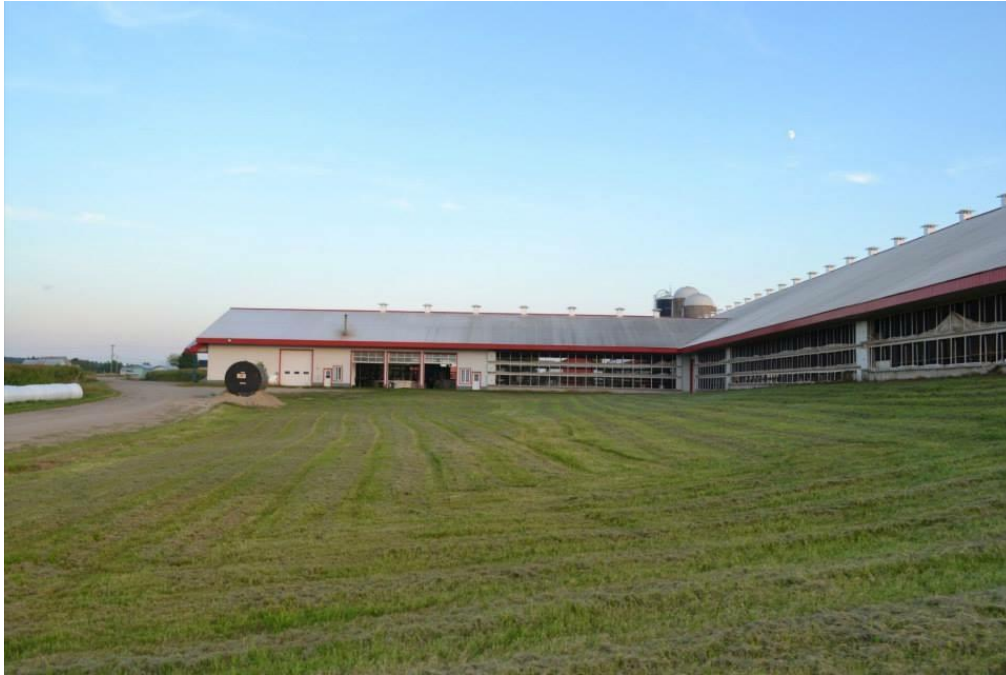
Figure 3-1 : Bâtiment d'élevage existant #2
