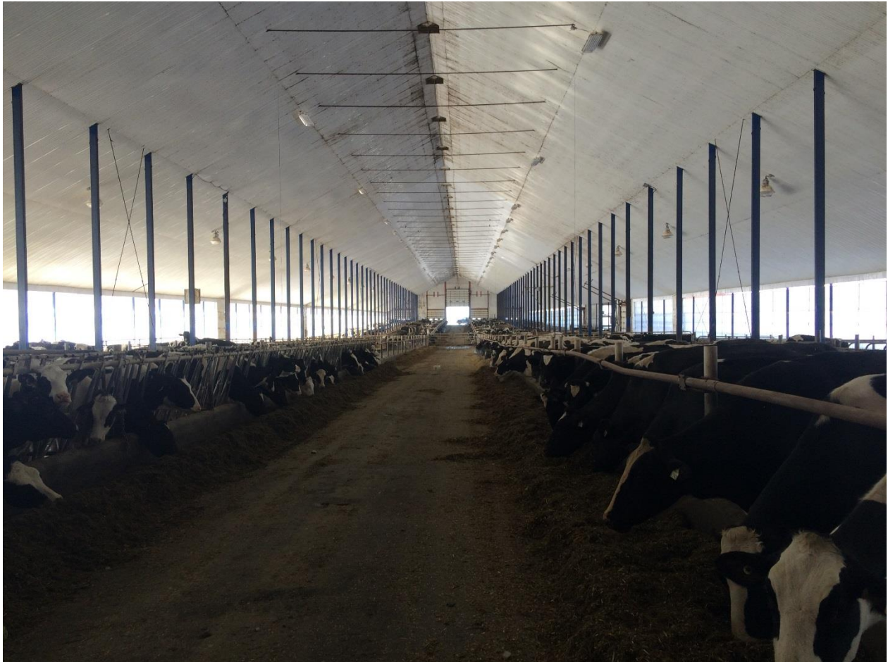
Figure 1-2 : Vue intérieur du bâtiment d'élevage #2
