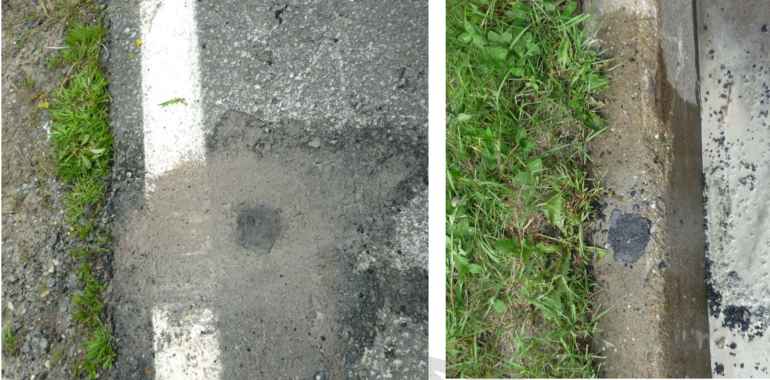
Figure 5 Réfection à l'aide d'asphalte froid.
