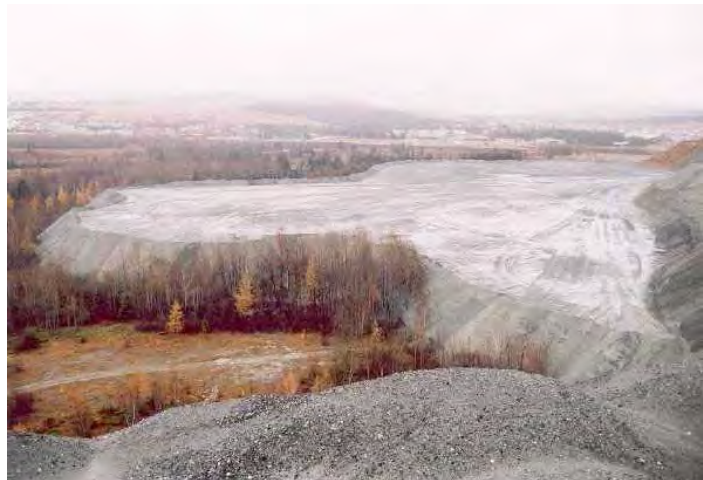
Figure 2.13 : Parc à résidus de la mine Bell dont les rejets sont déposés par camions (Huot, 2003)
