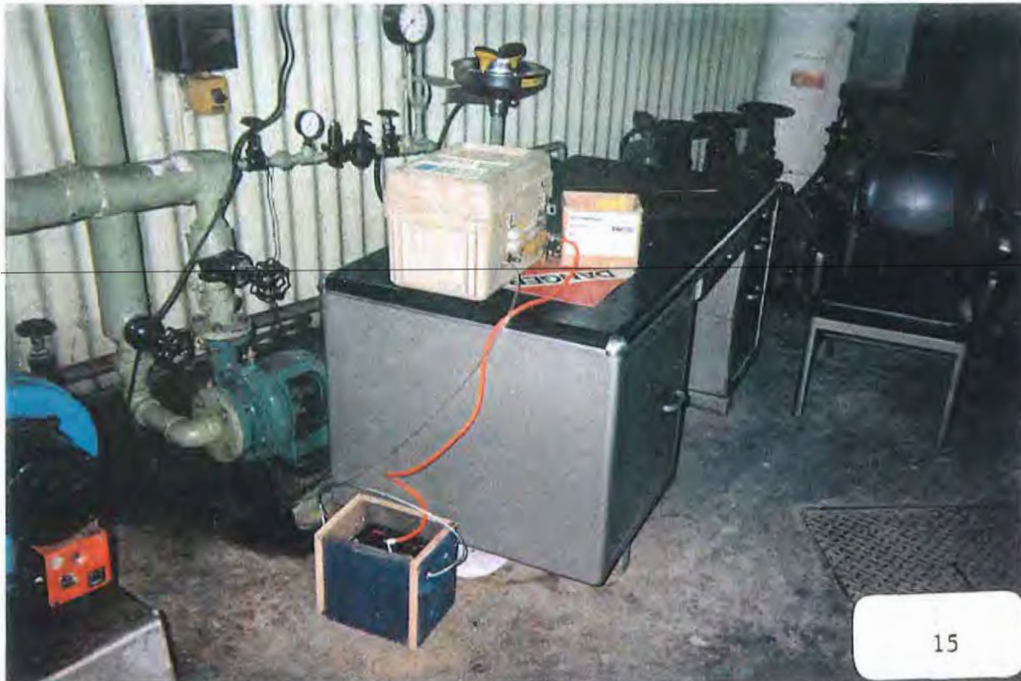
J.M.4 Installation des équipements
