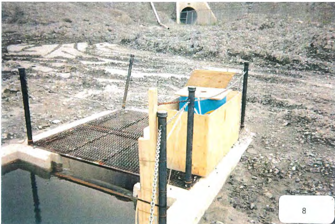
J.M.3 Site du point d'échantillonnage et de mesures de débit
