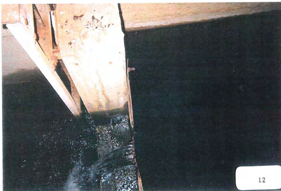
J.M.4 Déversoir en V 90°
