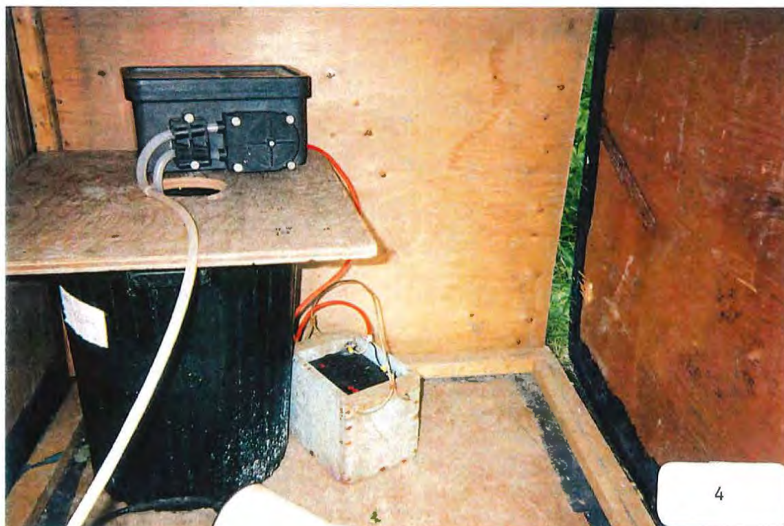
J.M.2 Installation des équipements
