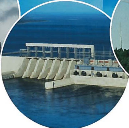
Centrale hydroélectrique La Grande-1
