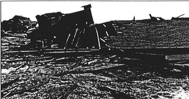
Domages faits par une tempête de vent
