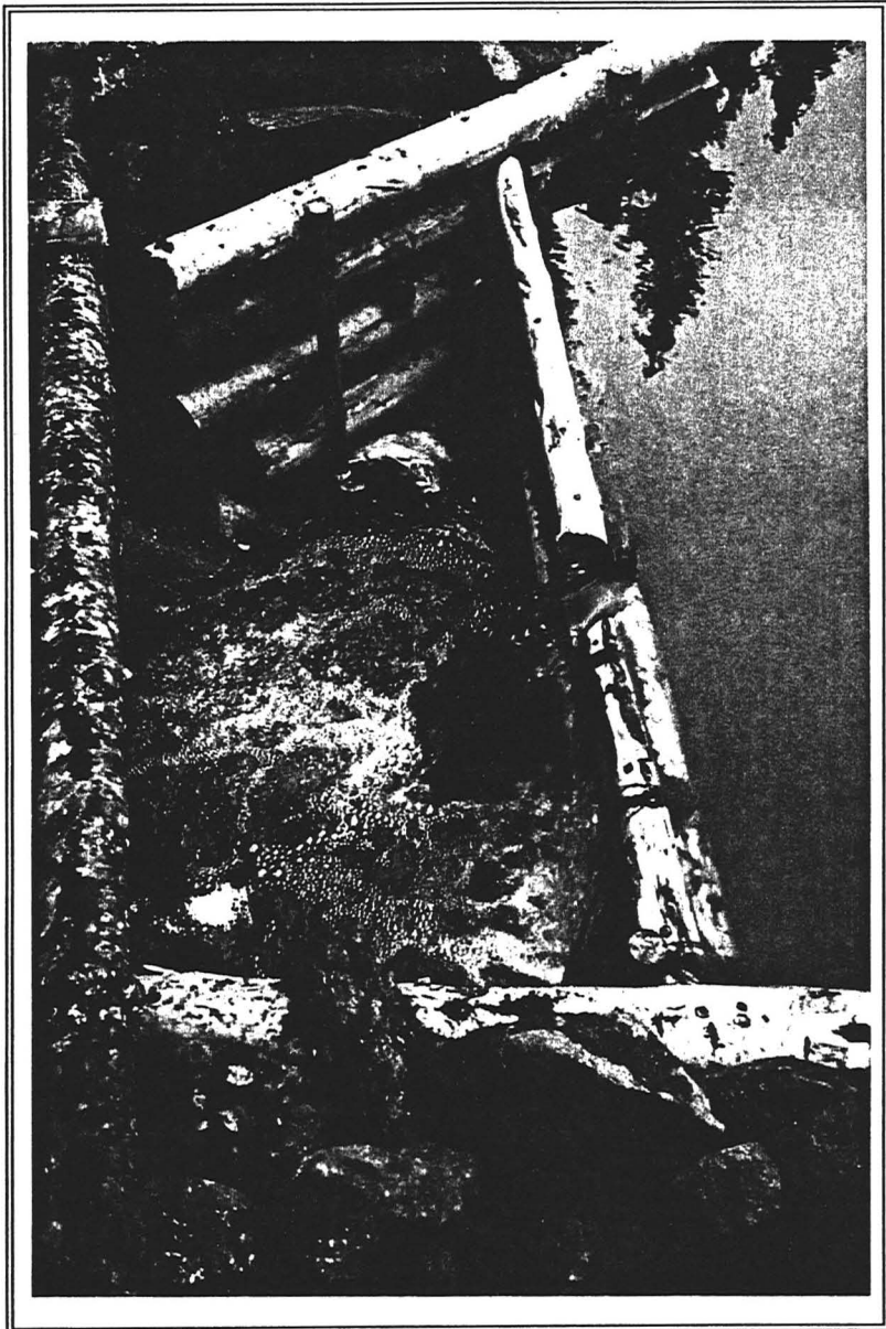
Photo 7. Seuil en bois aménagé.
