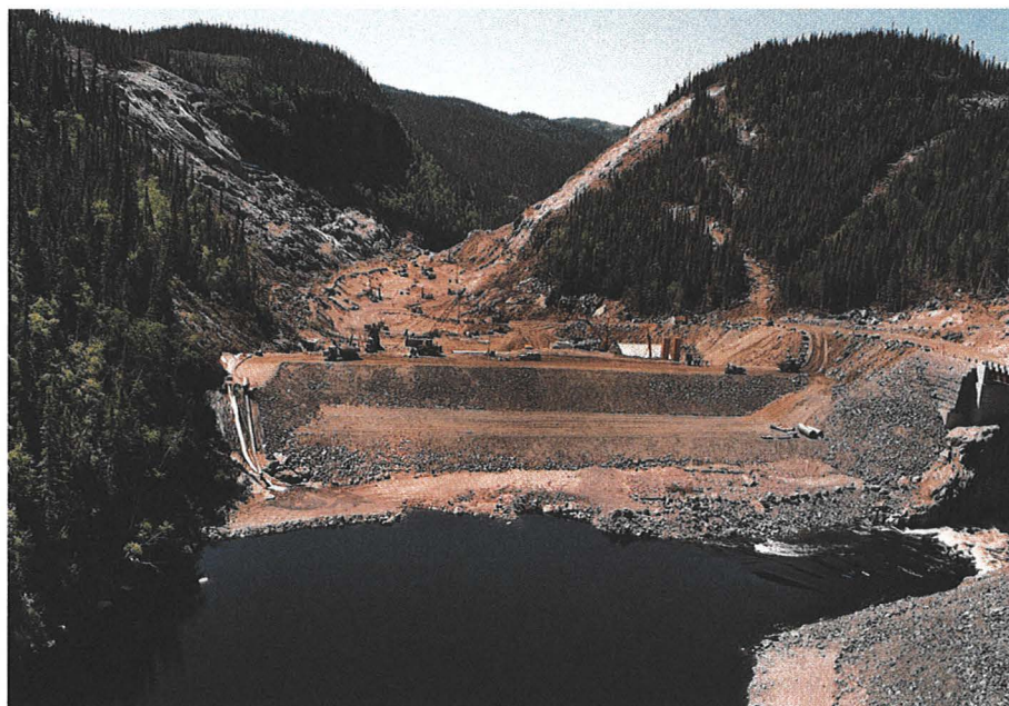
Chantier de la Sainte-Marguerite-3
