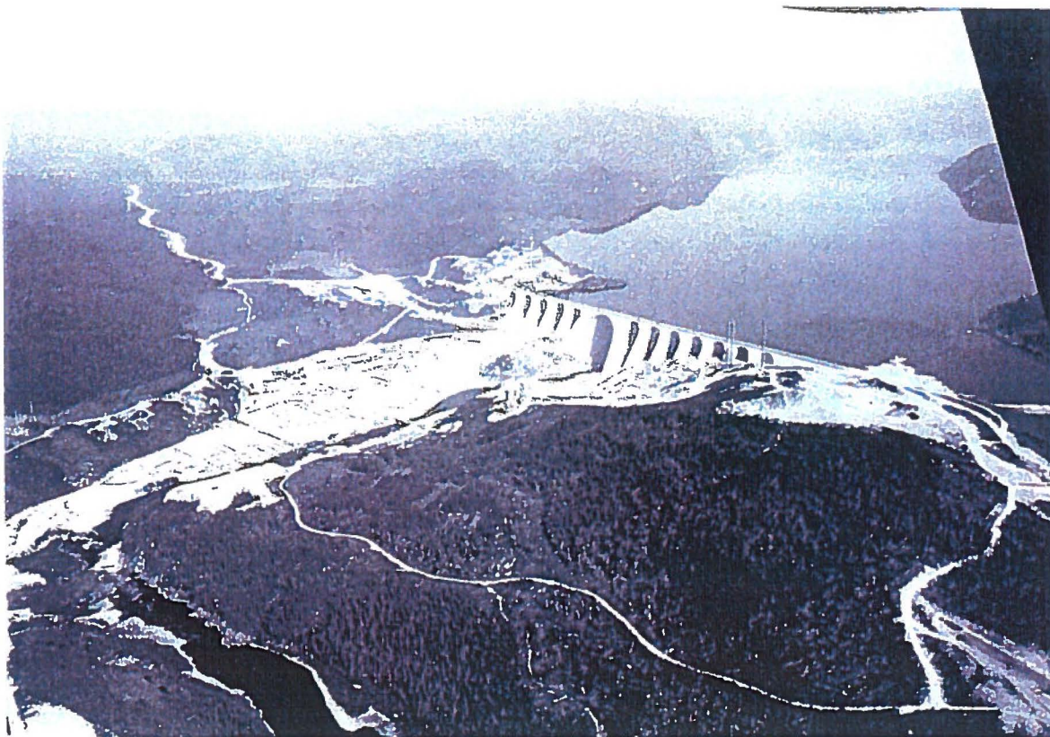
Photo 21. Vue du barrage de Manic 5 situé à 50 km au sud du réservoir Manicouagan (Gilles Gagnon, 76-77)
