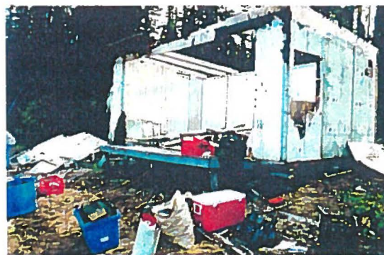
Photo 5. Cabane en démolition, occupation illégale (Yves Lachance, 2001)
