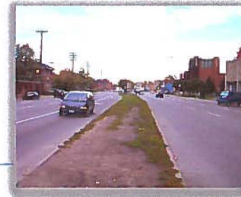
General view of King Edward Avenue at the intersection of Rideau Street Vue d'ensemble de l'avenue King Edward à l'intersection de la rue Rideau
