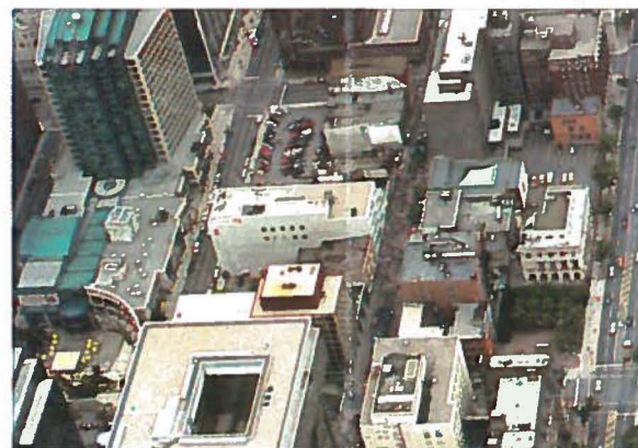
Aerial View of Existing Conditions / Vue aérienne de la situation actuelle
