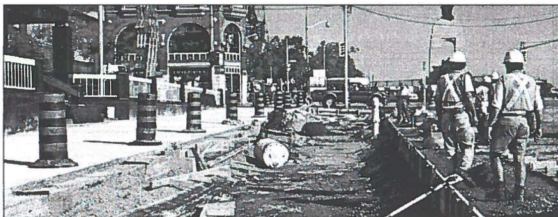
Le boulevard de la Confédération (segment de la rue Elgin) en construction, 1999
