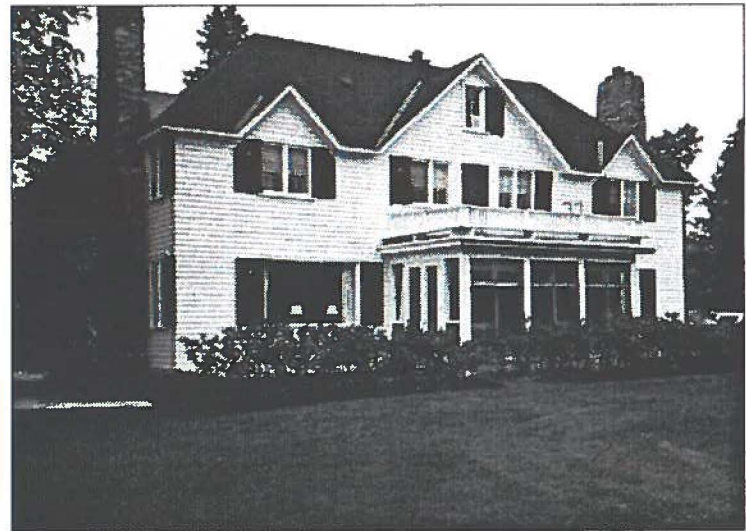
Lac Harrington – résidence secondaire du premier ministre du Canada
