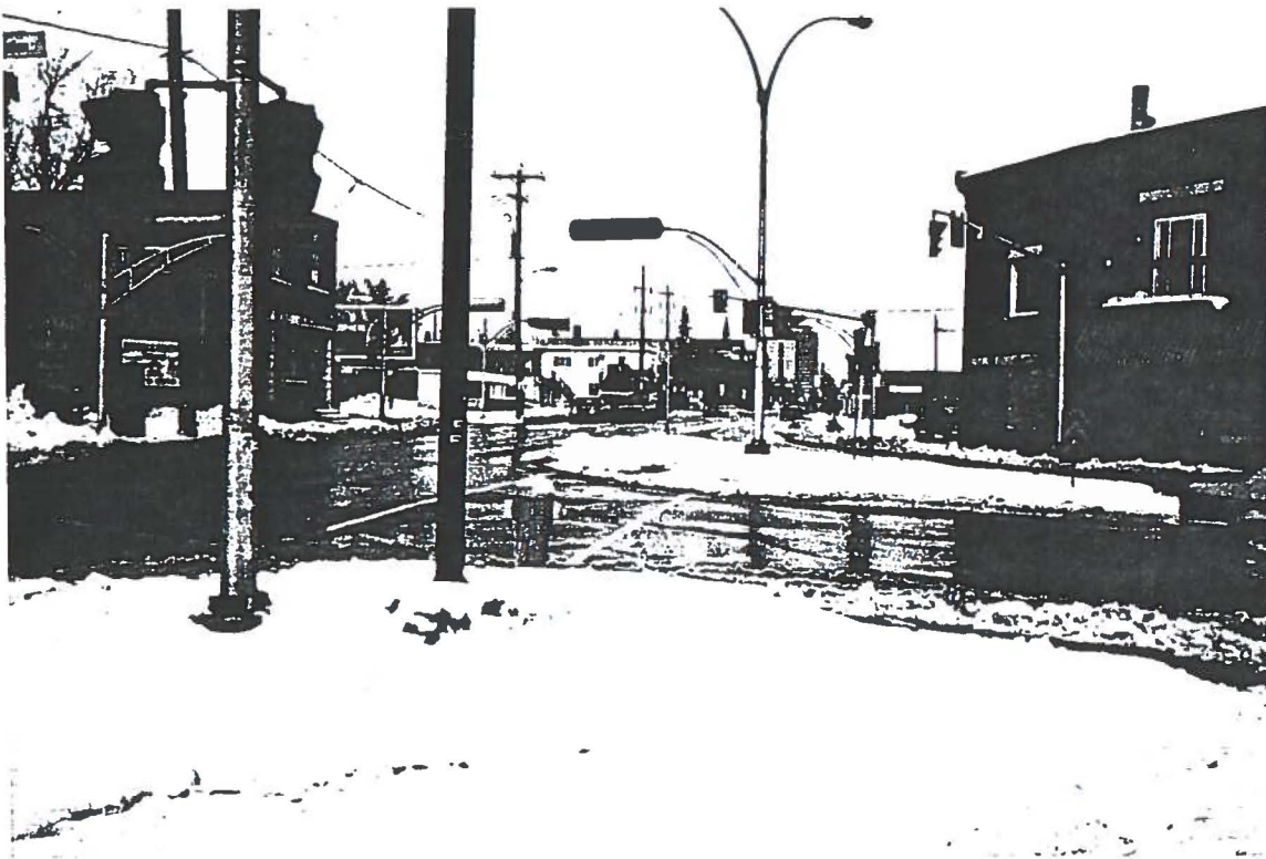
Intersection Montcalm/Laramée déficient pour le confort et la sécurité des piétons.
