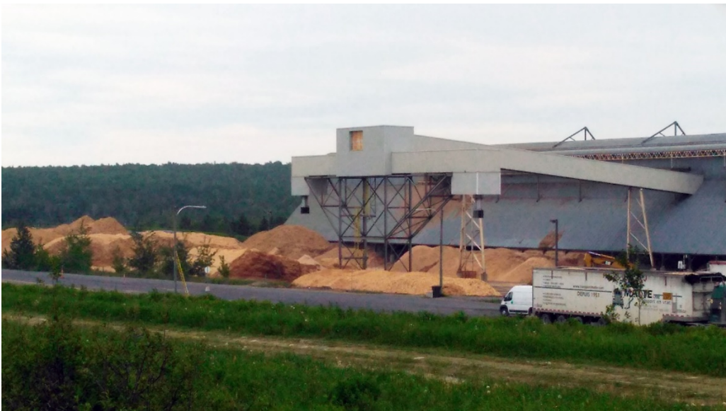
Photo-18 (Tracé proposé de voie de contournement situé à environ 150 mètres de l'Usine Tafisa, présence des accumulations de résidus forestiers hautement inflammables à l'extérieur de l'usine) (Brin de scie et copeaux)
