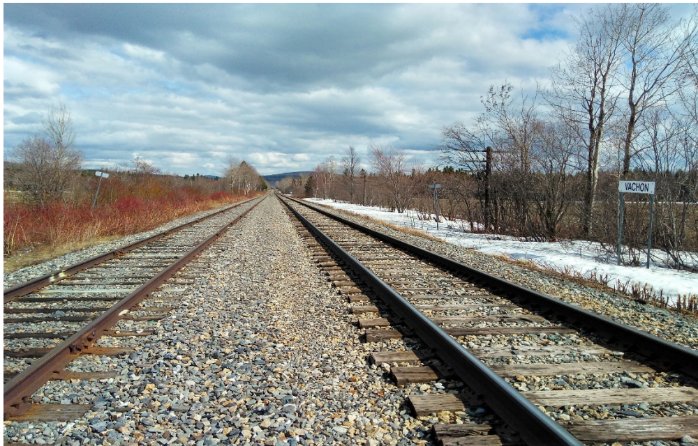
Photos-6 de la voie de desserte Vachon dans le secteur Frontenac d'une longueur de 6470 pieds
