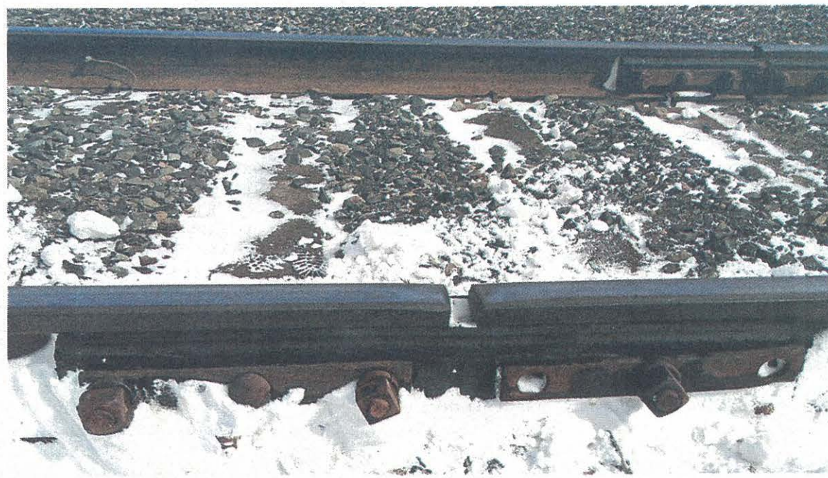
Un citoyen a pu constater qu'une éclisse retenant un rail de la voie ferrée ne tenait que grâce à un seul boulon tordu, alors qu'en temps normal, il y aurait dû y avoir trois boulons en meilleure condition. — PHOTO FOURNIE PAR LA COALITION
