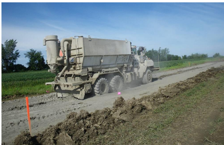
Figure 2.1 Construction d'un chemin (source : Kruger Énergie)
