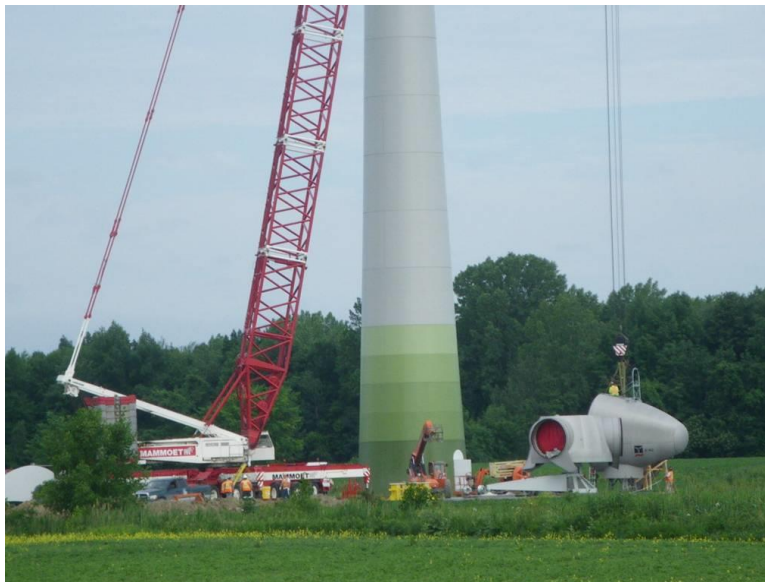
Figure 2.5 Montage d'une éolienne (source : Kruger Énergie)
