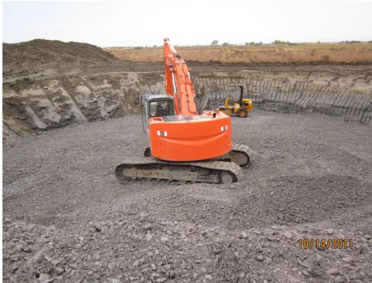
Figure 2.4 Préparation des fondations d'éoliennes (source : Kruger Énergie)
