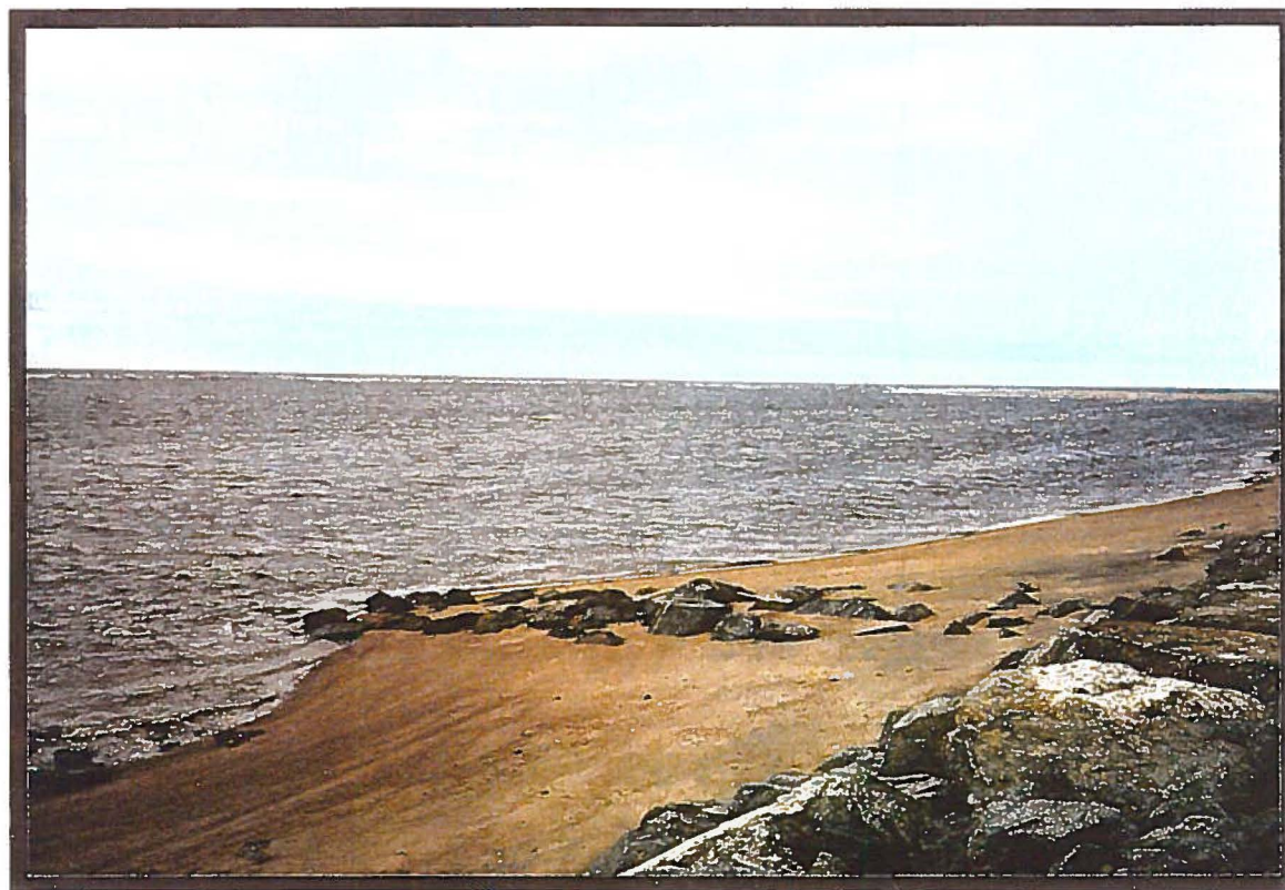
Figure 12 Protections en enrochement avec épis rocheux à Gallix
