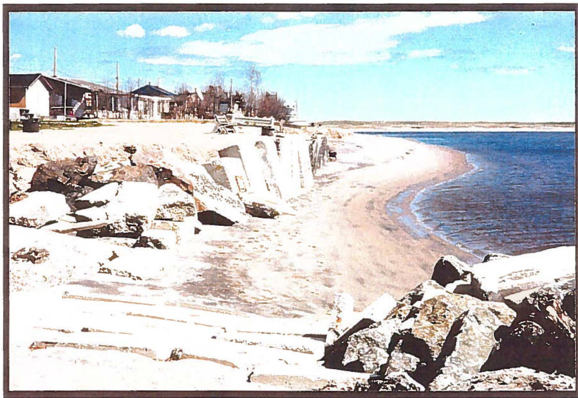
Figure 38 Érosion et protections de berge artisanales à Val-Marguerite, juin 1997
