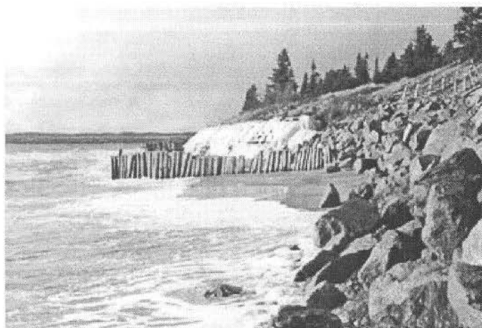
Dans la péninsule de la Manicouagan, plusieurs formes de protection des rives ont été tentées en vain. - Photo Michèle Roberge
