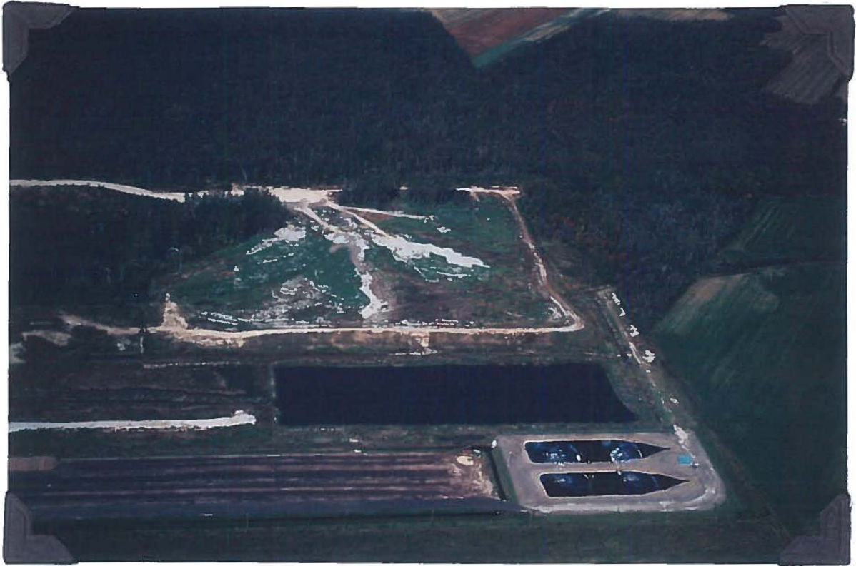
Système de traitement des eaux de lixiviation (L.E.S. et compostage). Il comprend: un bassin tampon, deux bassins d'oxydation biologique (lagunes aérées facultatives) et un système de désinfection aux rayons ultraviolets.
