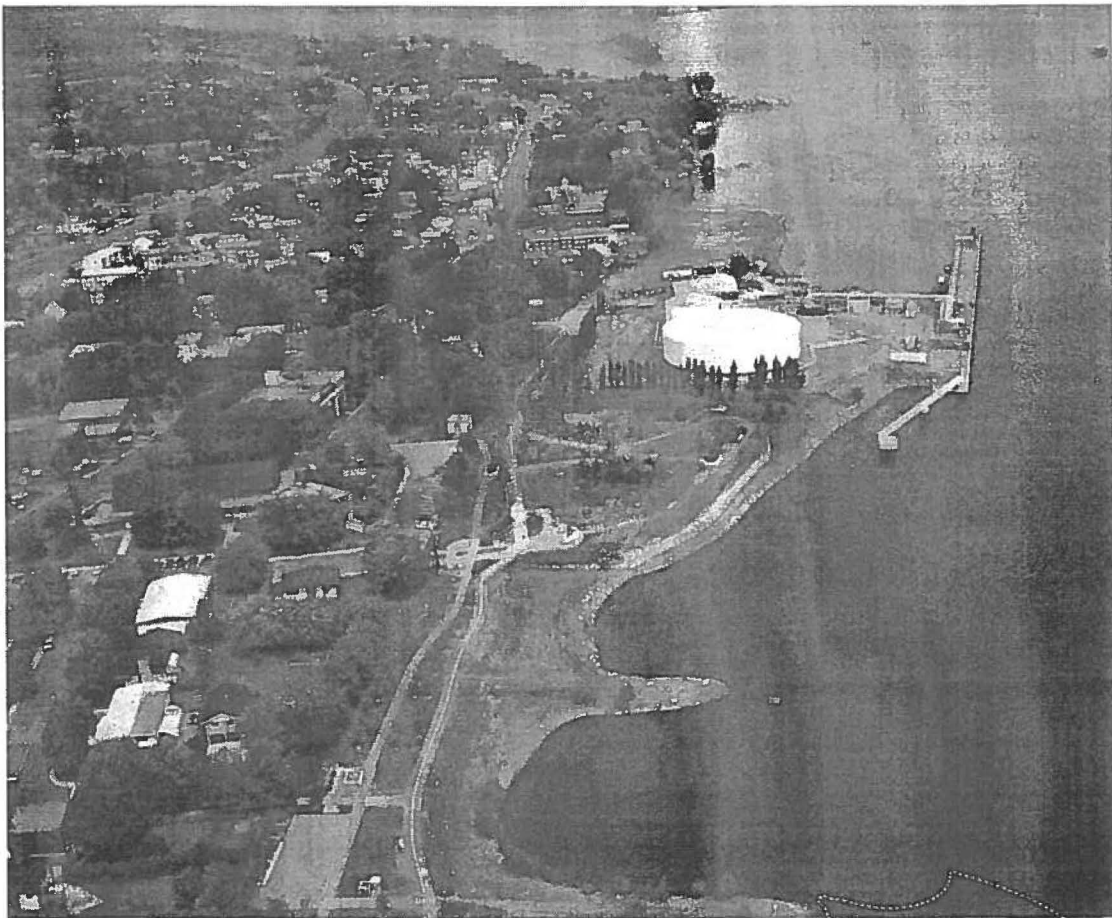
Quai pétrolier dans le secteur Montréal-Est
