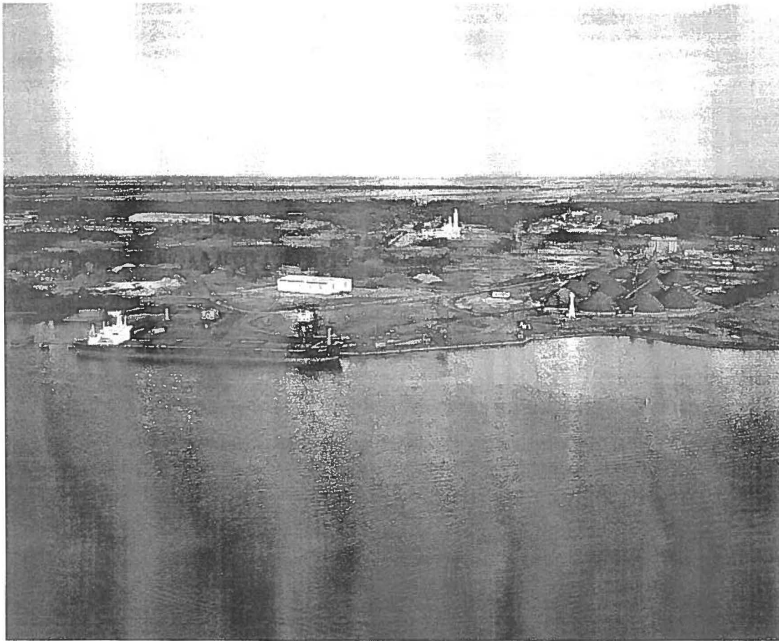
Terminal de vrac solide dans le secteur Contrecoeur
