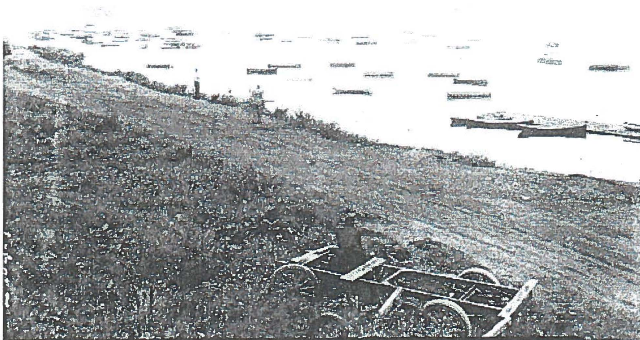
Vue du fleuve à la hauteur probable de la rue Létourneux en 1936
