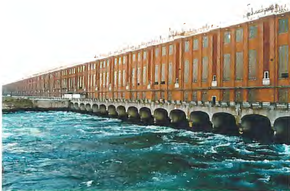
Photo 4 : Centrale hydroélectrique de Beauharnois – Point repère visuel (UPM)
