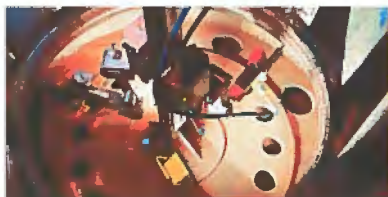
Réparation d'une roue de turbine. Les travaux sont facilités par le robot Scompi.
