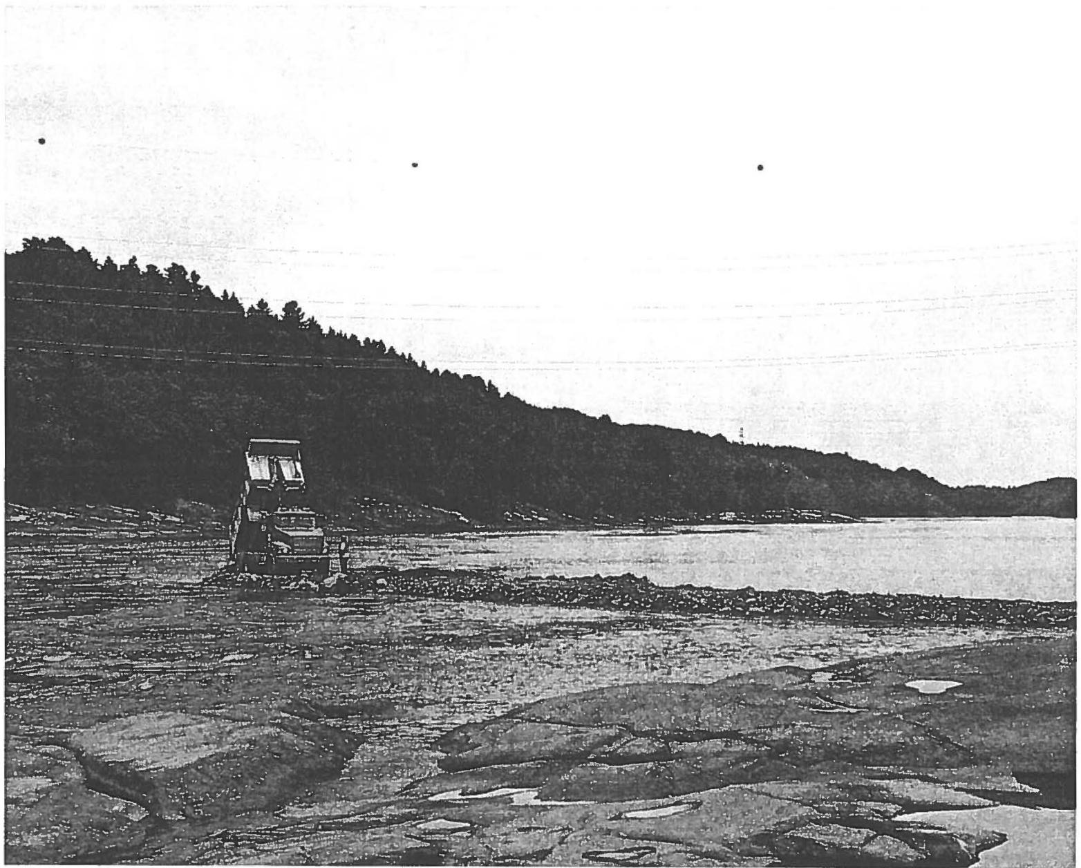
Acheminement des matériaux
