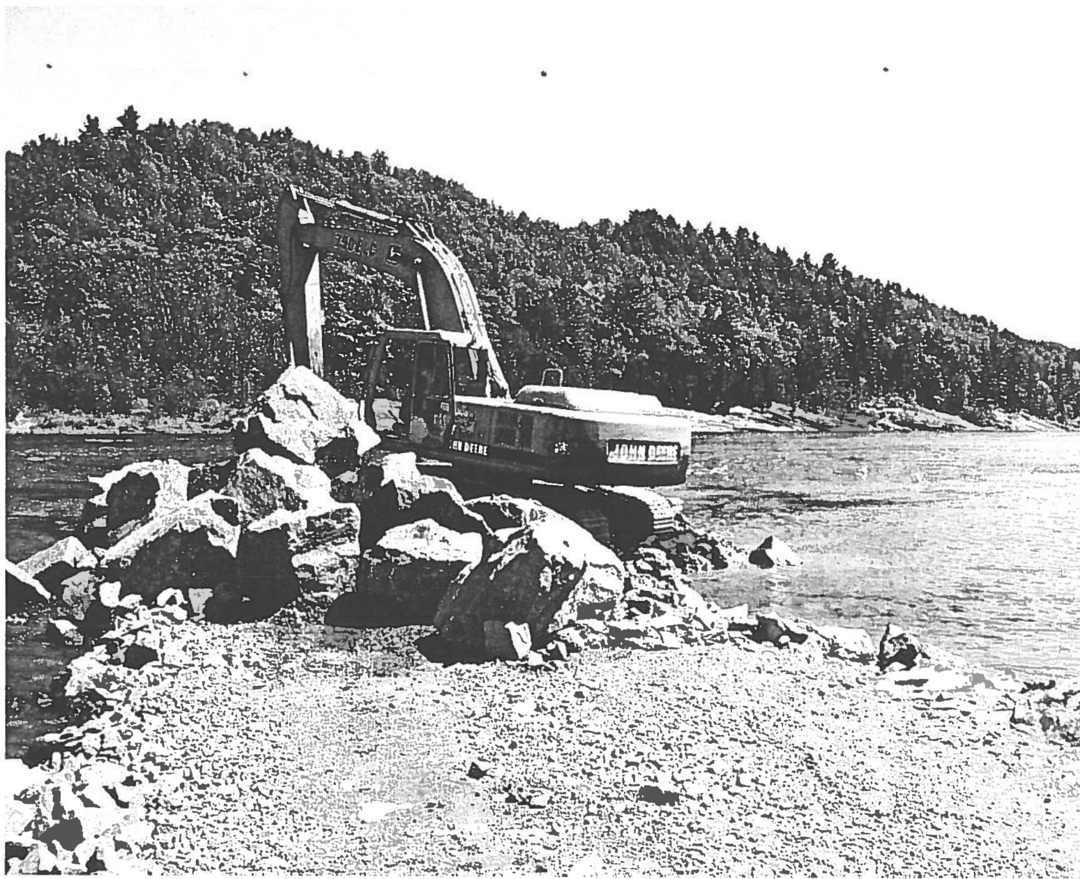
Aperçu des blocs utilisés pour construire les abris de courant
