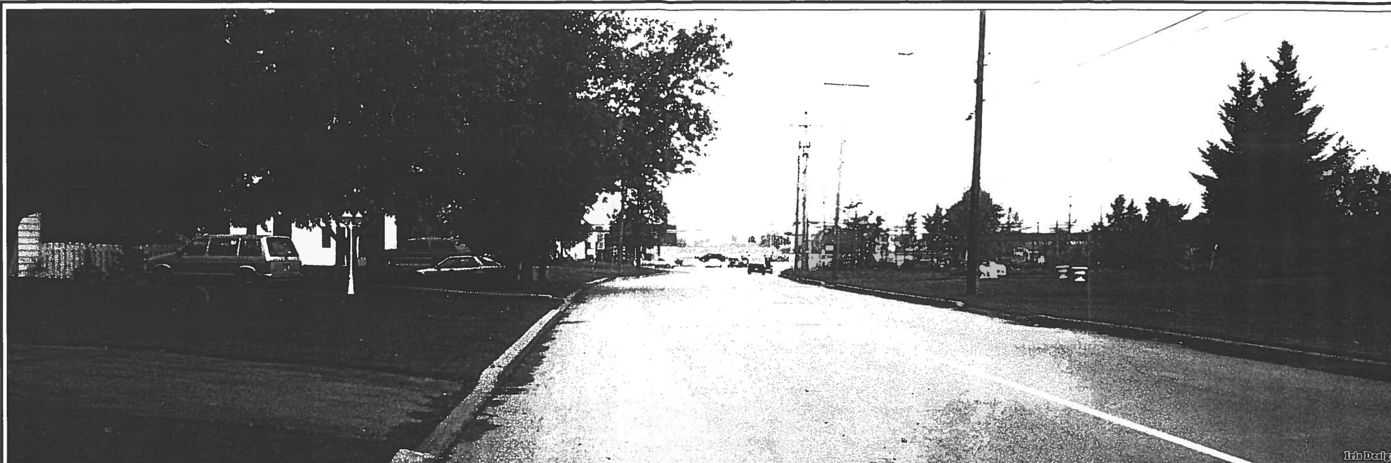
Figure 17. 8a : Point de vue à partir de la rue Principale vers la route 132 – Avant aménagement
