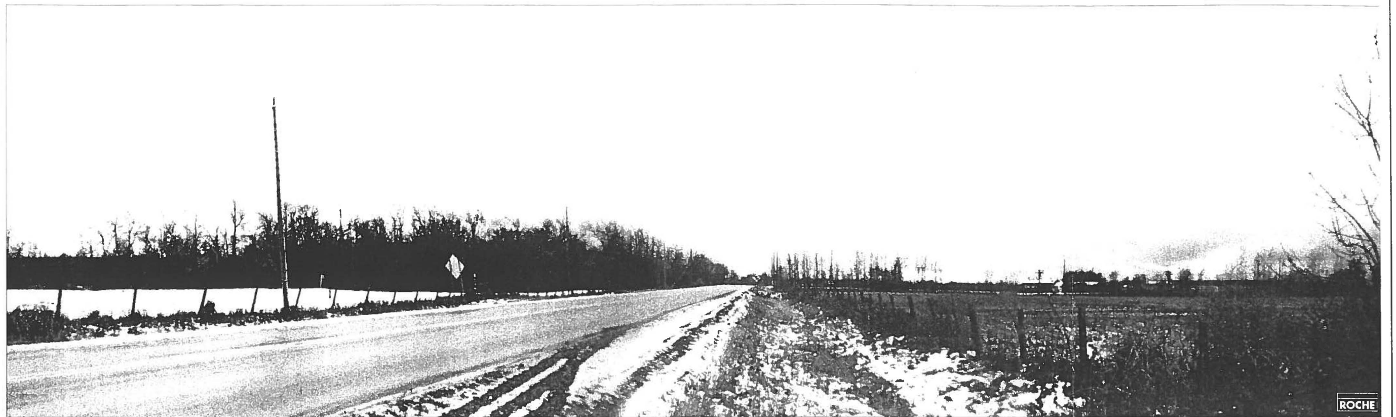
Figure 17. 6a : Point de vue à partir du rang de la Petite-Côte vers le sud (corridor sud) - Avant aménagement
