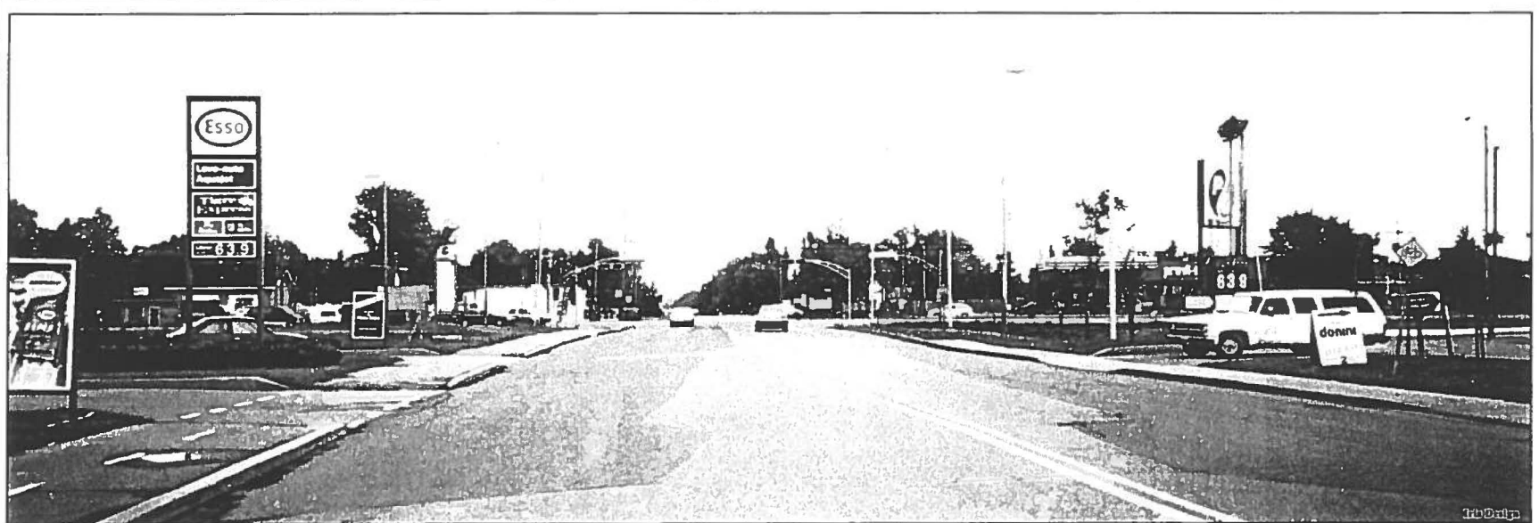
Point de vue à partir de la rue Monchamp vers la route 132 – Avant aménagement
