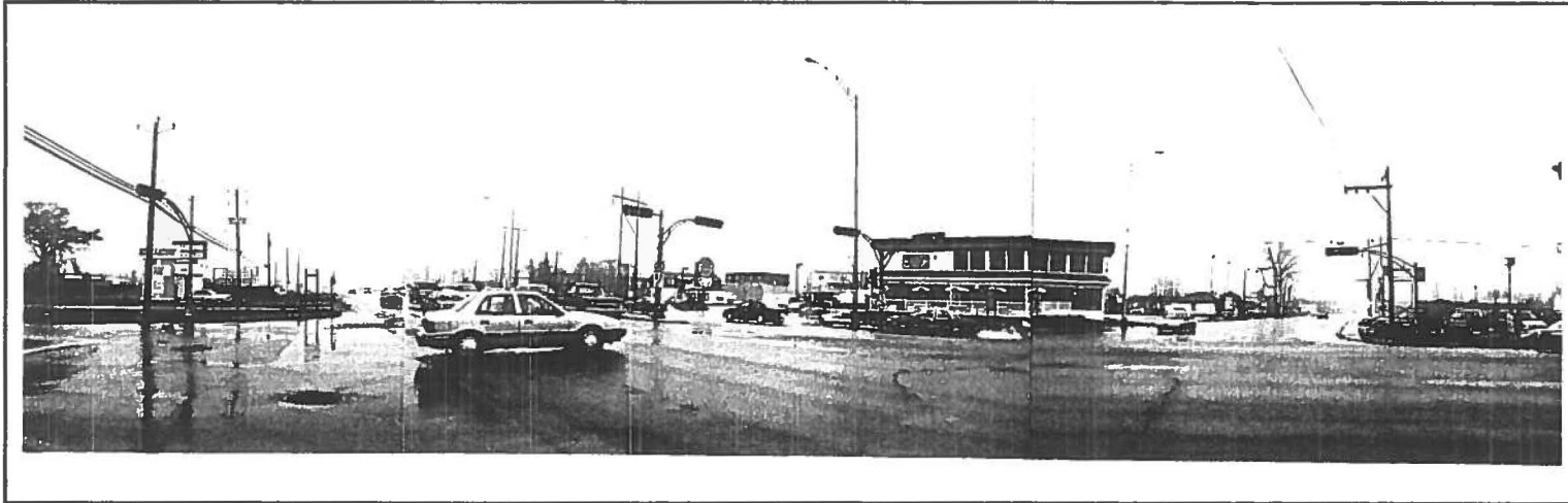
PHOTO 10.12 - Unité de paysage 5c - Le paysage à l'intersection de la rue Saint-Pierre est chargé et complexe visuellement (ligne hydroélectrique, poteaux, panneaux, enseignes, etc.). Il présente très peu d'intérêt visuel; au contraire, il nuit à la lisibilité du réseau routier.
