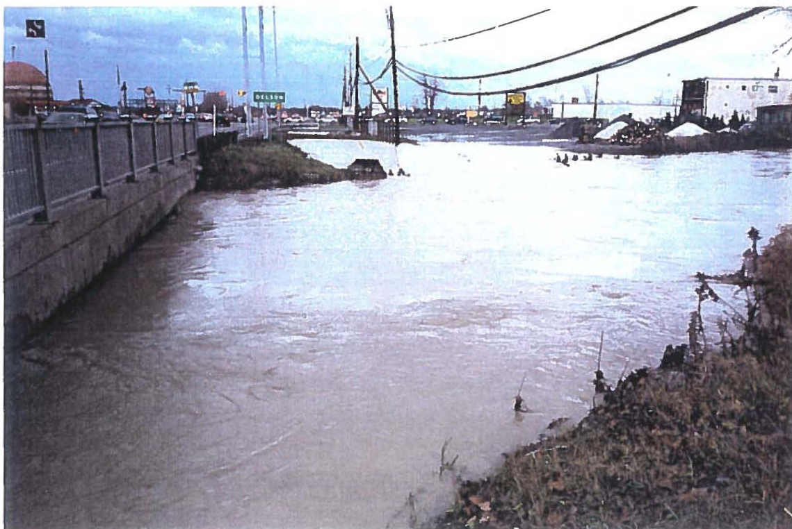
Événement du 8 et 9 novembre 1997 - Pont de la route 132 (riv. St-Pierre) 6
