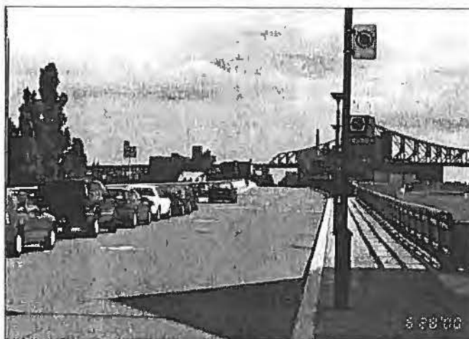
Photo A8 Vue du viaduc vers l'est
