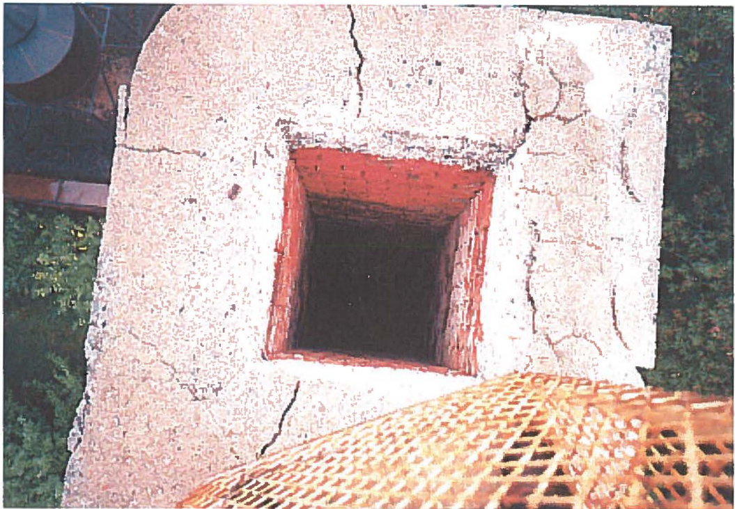
Photo 21: Cheminée: détail de la couronne.
