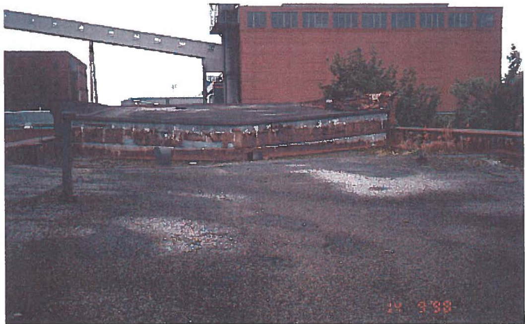
Photo 13: Toit - Section B & A (vue du toit)
