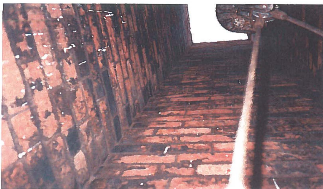
Photo 24: Cheminée: vue intérieure (3 @ 25 pieds).
