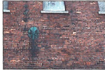
Photo # 6.- Esse en métal liant l'ossature à la maçonnerie
