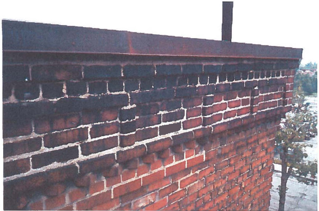
Photo 3: Parapet: façade sur Notre-Dame (section A)
