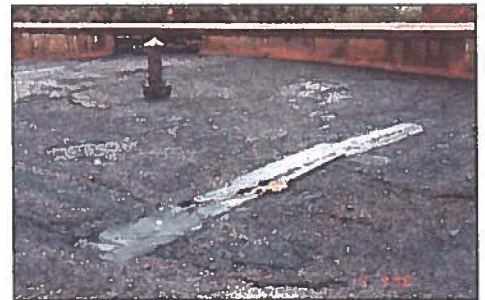
Photo # 28.- Anciennes réparations temporaires;
