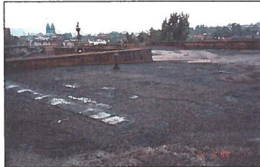
Photo # 27.- État général de toit sections B & C;
