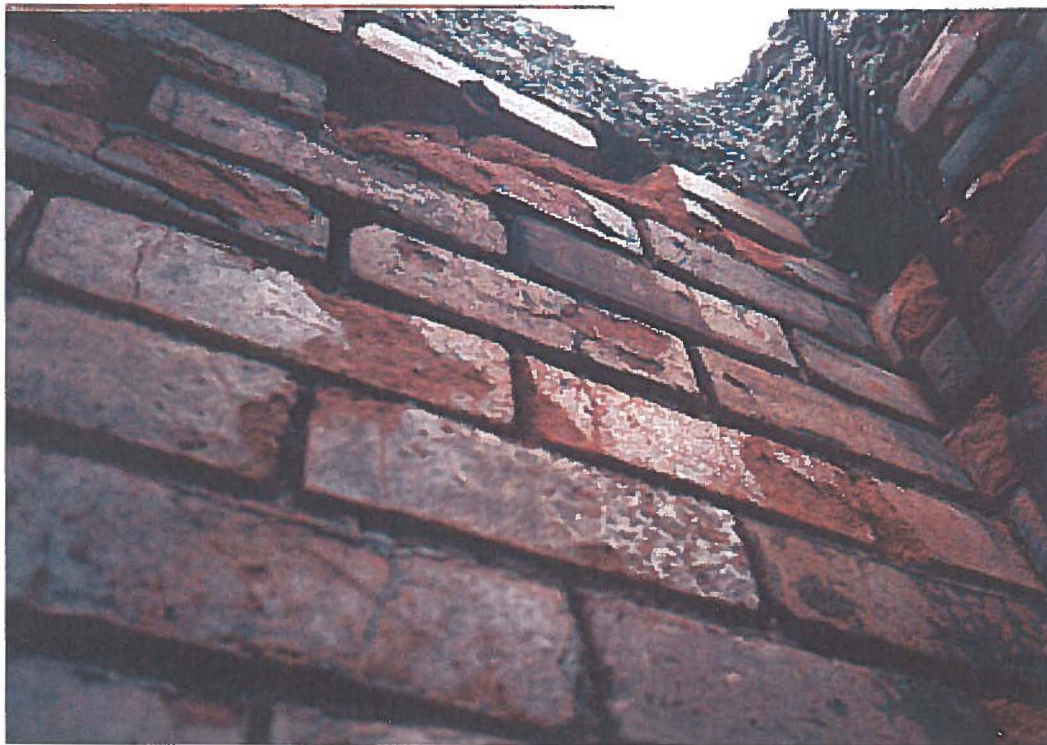
Photo 23: Cheminée: vue intérieure (0 @ 3 pieds).
