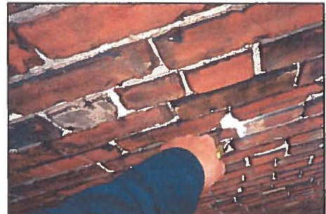
Photo # 13.- Mortier à base de chaux en sable aux étages supérieurs .
