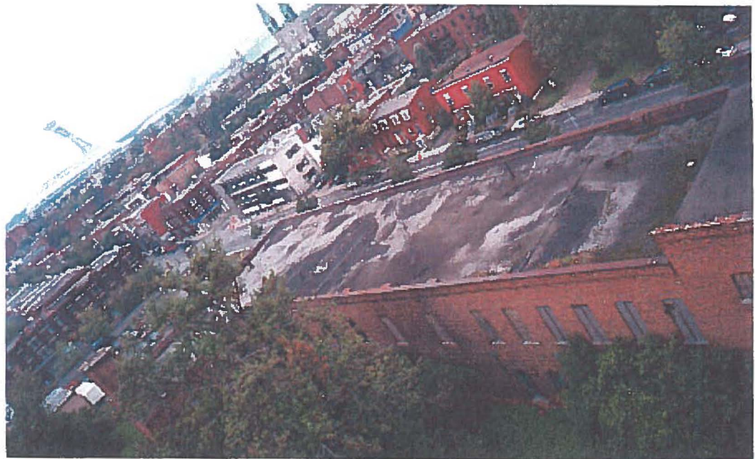
Photo 11: toit vue aérienne section B.
