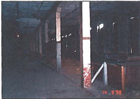
Photo # 5.- Ossature en bois d'oeuvre
