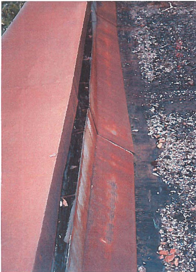
Photo 14: Toit détail de solin ouvert.
