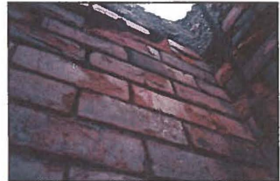
Photo # 31.- Cheminée, vue intérieure;
