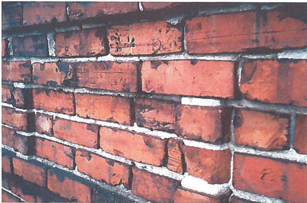
Photo 7: Haut du mur - détails.
