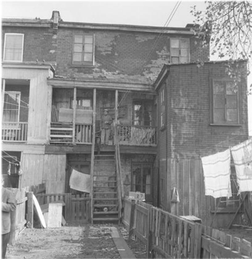
Figure 14 Maison de Victoriatown avant la démolition (VM94C270-0005_141)
