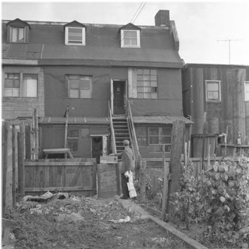
Figure 15 Maison de Victoriatown avant la démolition (VM94C270-0017_141)
