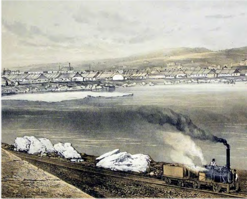
Figure 5 Les fever sheds, vus du chantier du pont Victoria (vue vers le nord-ouest). (Source : https://irishcanadianfaminerresearcher.wordpress.com/category/montreal-fever-sheds/ )
