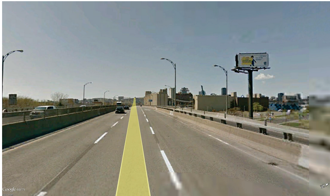
Photo 4-11 : Silos et silhouette de Montréal – Vue vers le nord depuis le segment surélevé de l'autoroute Bonaventure, à la hauteur du poste Viger (unité de paysage IND-02)
