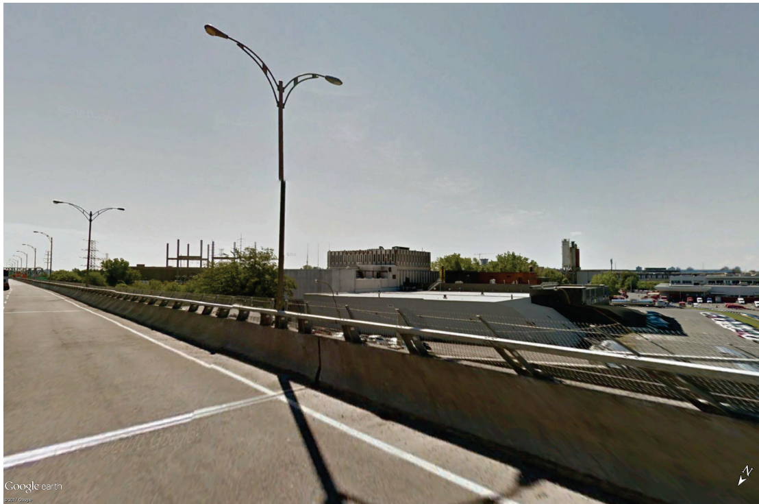
Photo 4-9 : Structures industrielles – Vue vers le sud-ouest depuis l'autoroute Bonaventure (unité de paysage IND-01)
