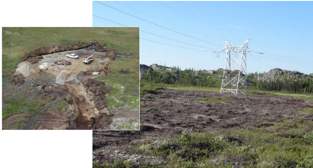
Photo.15: Réaménagement d'une aire de travail en milieu humide, projet de raccordement de la centrale de-du-Sault
