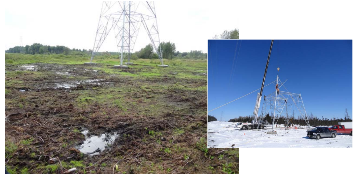
Photo.16: Réaménagement d'une aire de travail en milieu humide, projet de la ligne Figury-Palmarolle
