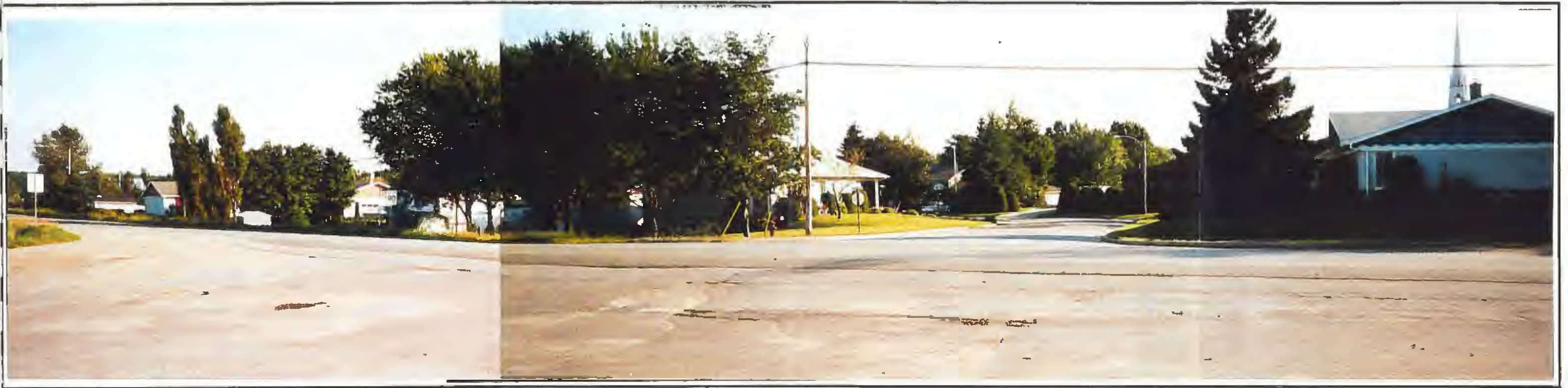
PHOTO 3- Vue vers le sud à la hauteur du périmètre urbain (unité 5). Noter la présence de l'église à droite (point de repère) ainsi que la proximité des terrains riverains.
