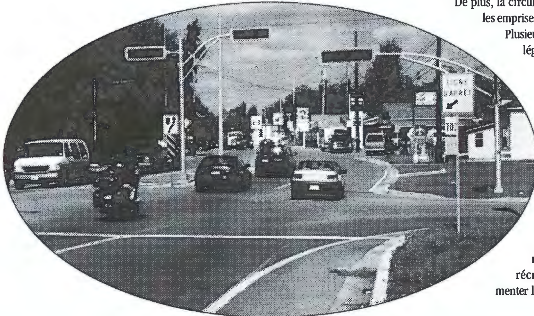
Perte de fonctionnalité du réseau routier : le cas de la route 344, Grenville.
