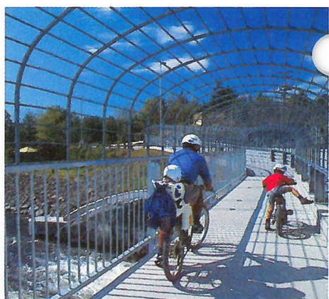
Passerelle du barrage à Dégelis
