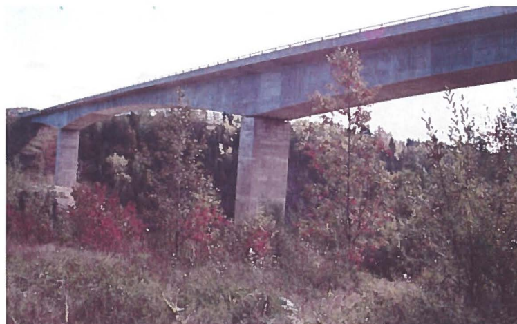
Pont de la rivière Rimouski – autoroute 20
