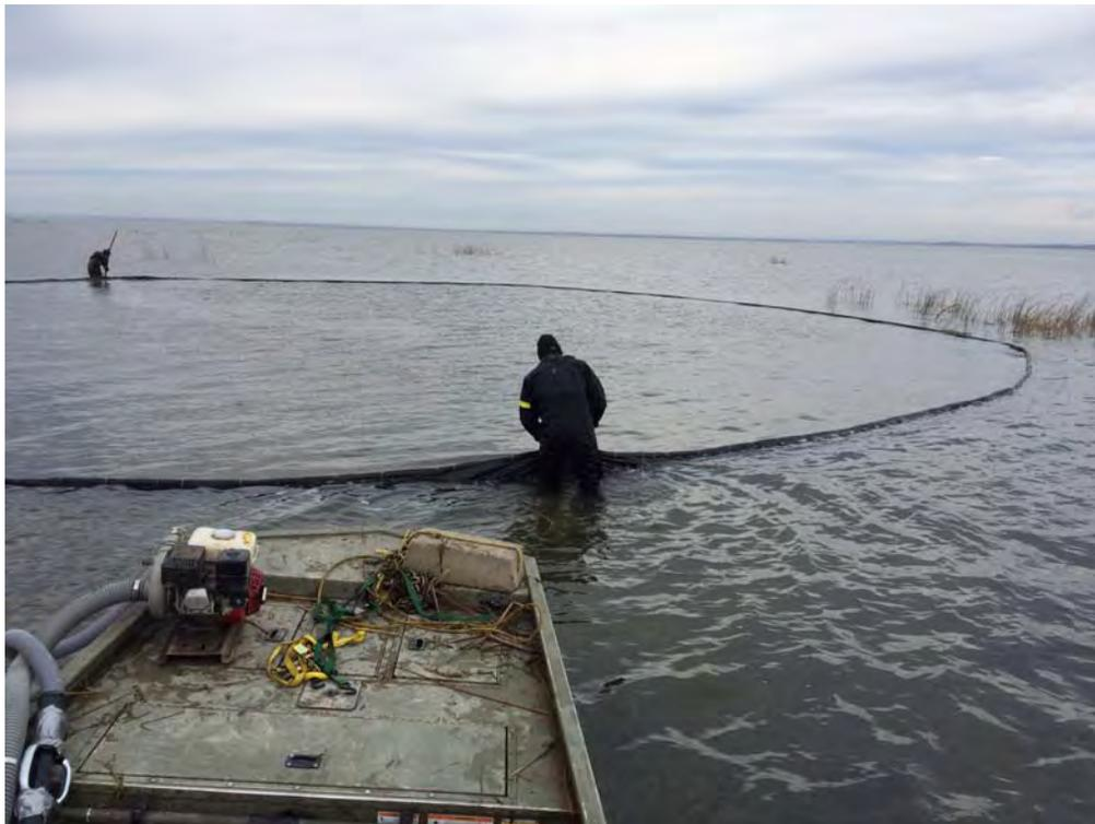
**Photographie 8 Batardeau du projectile B2-0215 – installation du batardeau**
