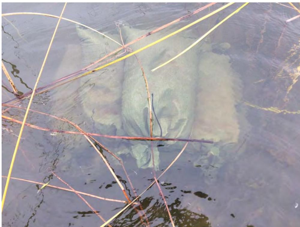
**Photographie 3 Confinement des projectiles par sacs de sable**
