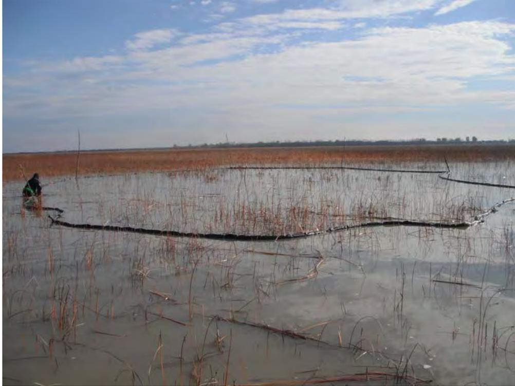
**Photographie 9 Batardeau du projectile B2-0240 – Installation du batardeau**
