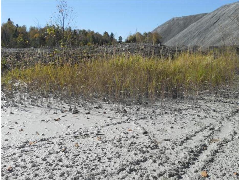
**12d)** Des fibres d'amiante sont visibles à la surface du sommet des haldes de résidus à pentes abruptes de la mine King-Beaver.
