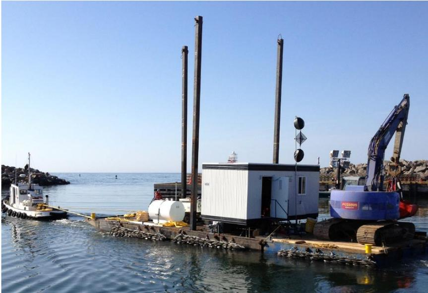
Figure 16 Barge de dragage
