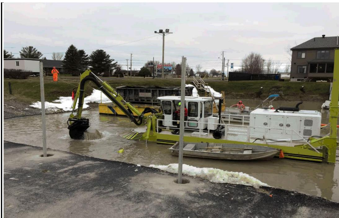
Figure 11 Drague Amphibex en opération dans le canal 3 en 2016.
