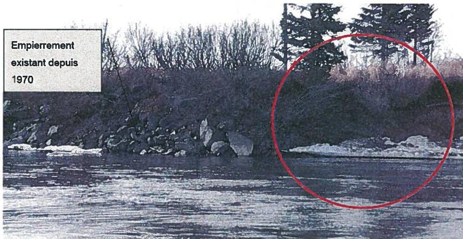
a) Localisation d'un foyer d'érosion provoqué par l'empierrement existant
